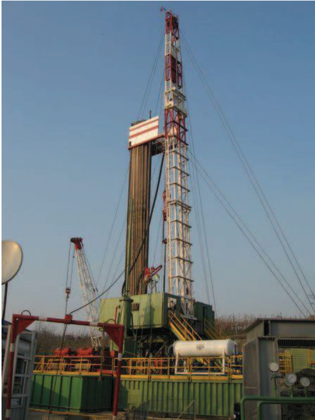
fig. 2.9 - Immagine impianto di perforazione MR 4000
