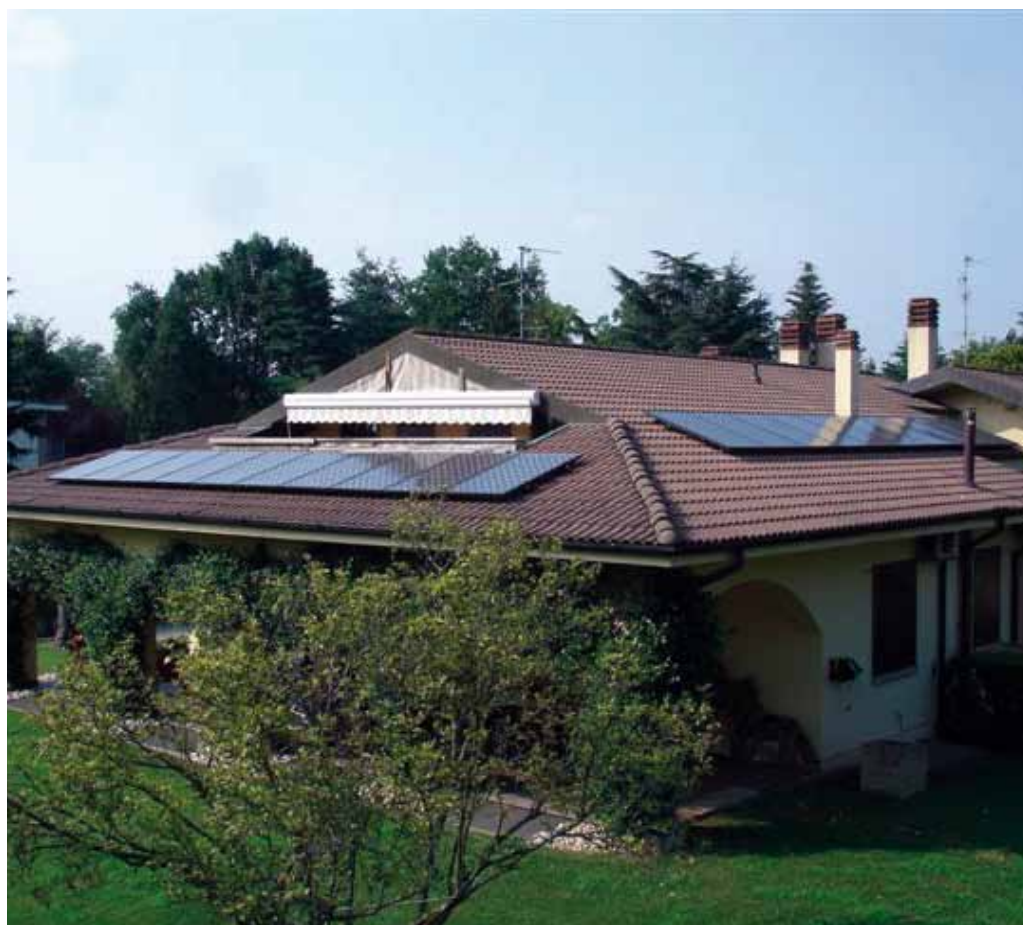
Impianto solare termico su abitazione privata
