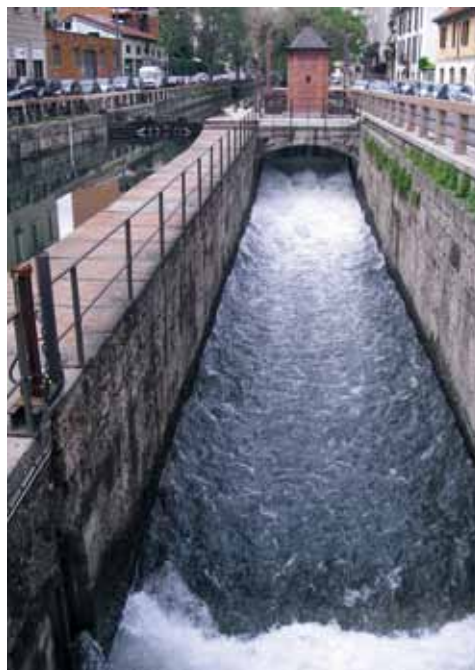
Impianto mini idroelettrico nel Comune di Milano
