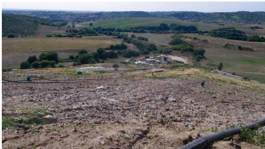
Pozzi di captazione su discarica per impianto a biogas
