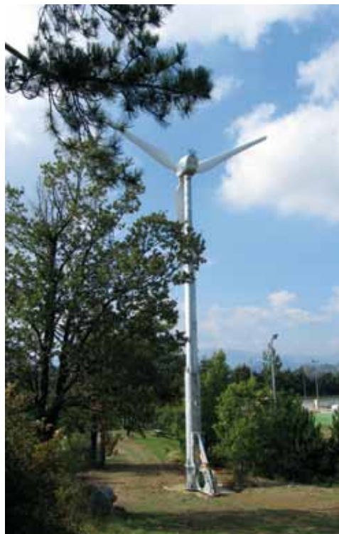
Pala eolica da 50 kW presso il campo sportivo del Comune di Peglio (PU)
