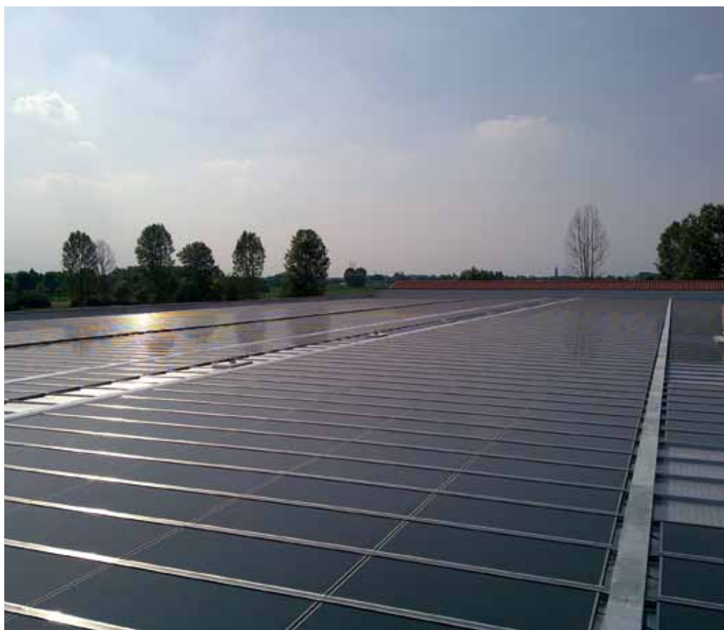
Tetto fotovoltaico dell'azienda "Veneta Agricola" ad Ospedaletto Euganeo (PD)
