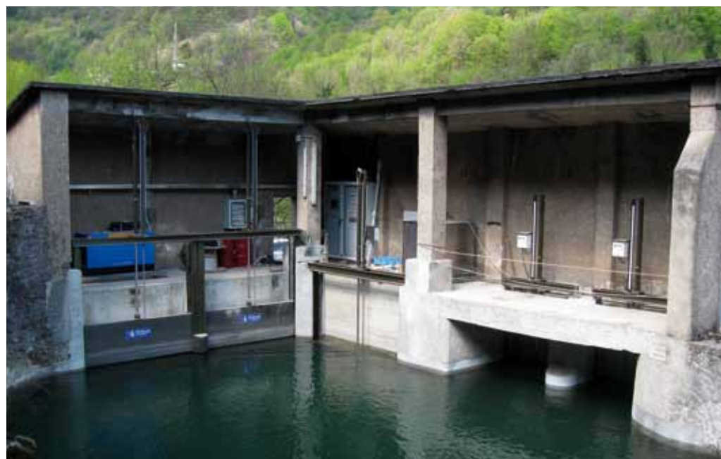
Rifacimento impianto idroelettrico di Mese (SO)
