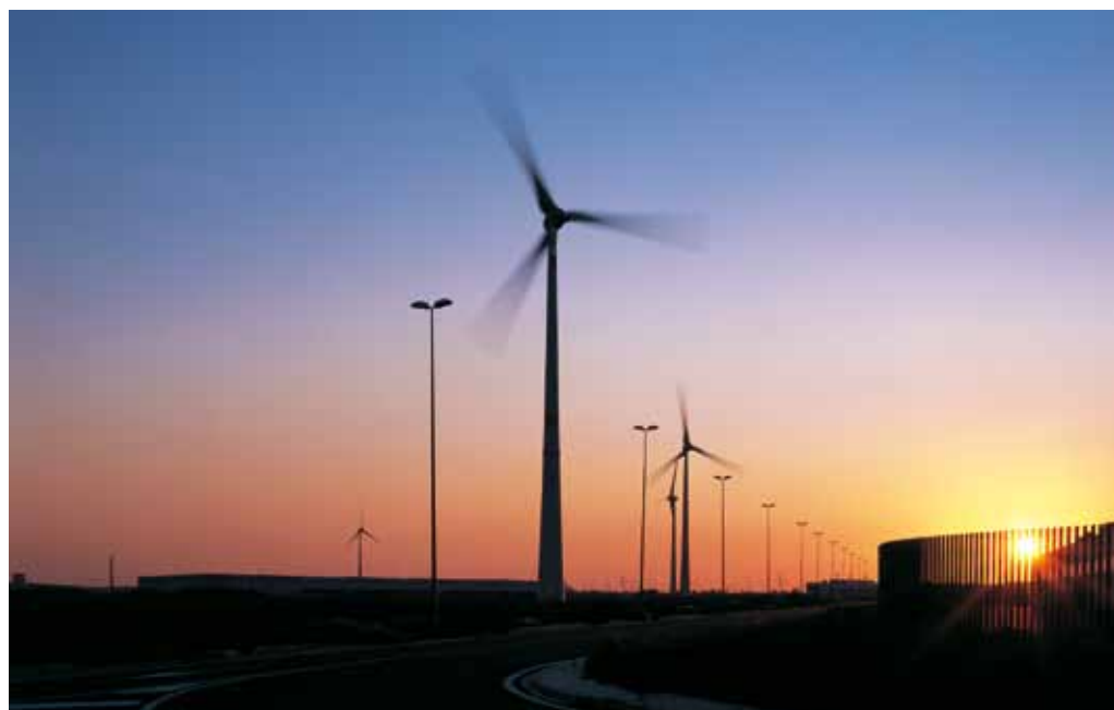
Parco eolico di Pontedera (PI)
