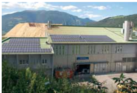
Impianto a biomassa del Comune di Brunico con pannelli fotovoltaici sulla copertura
