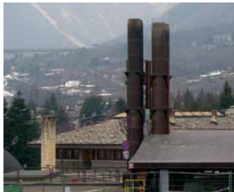
Impianto a biomassa del Comune di Morigex (AO)
