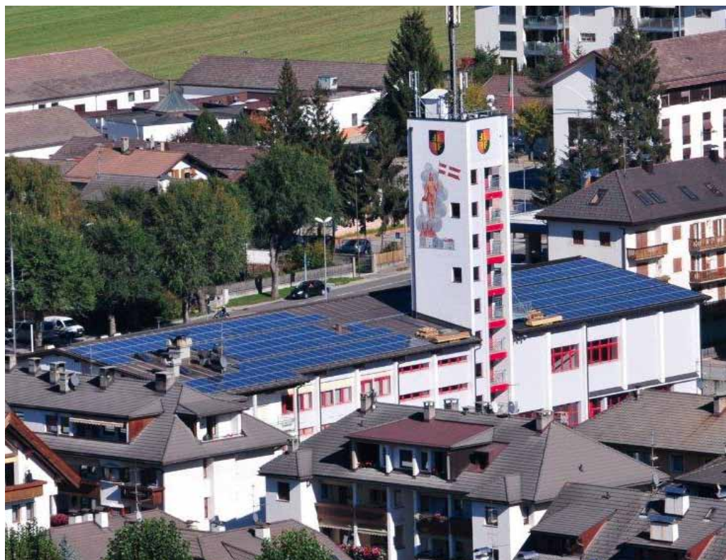
Impianto fotovoltaico integrato sul tetto della caserma dei Vigili del Fuoco di Brunico (BZ)
