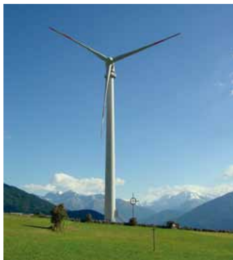
Impianto eolico nel Comune di Sluderno (BZ)
