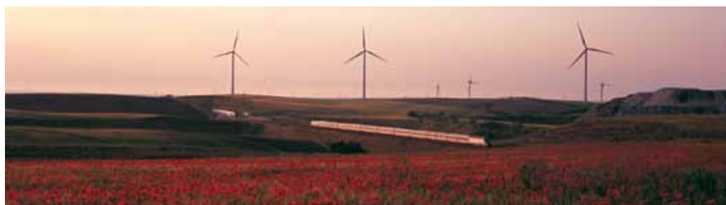
Parco eolico di Poggio Imperiale (FG)
