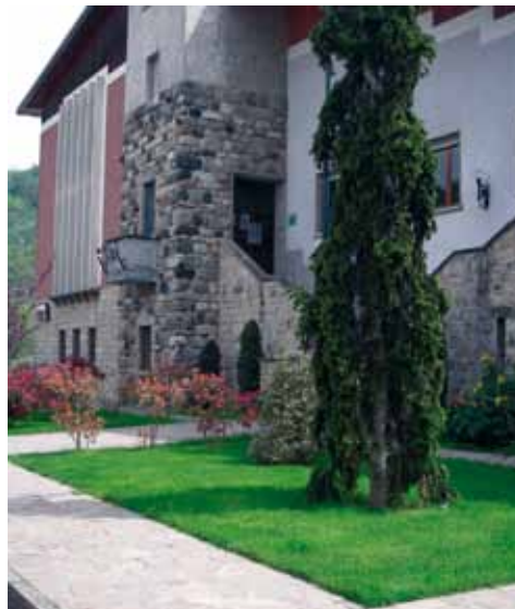
Edificio riscaldato con micro rete di teleriscaldamento nel Comune di Farini (PC)
